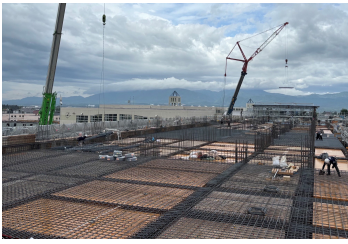
▲3階床工事の様子
