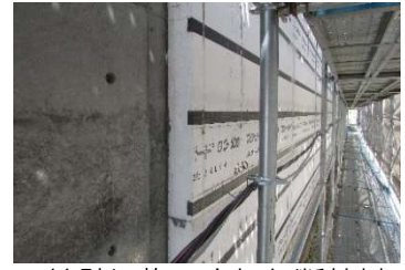
▲外壁に施工された断熱材
