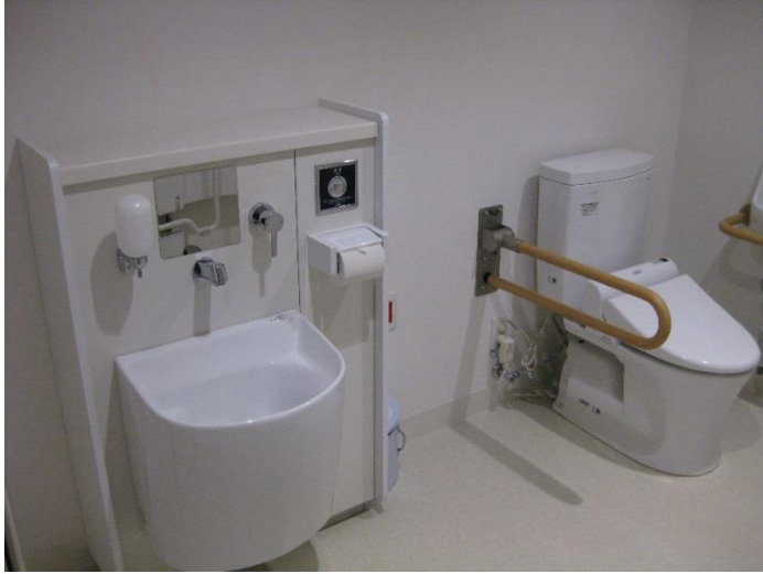
多目的トイレ
