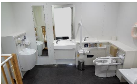
【多目的トイレ（幕別町役場）】
