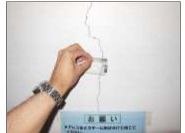
【室内コンクリート壁のクラック】
