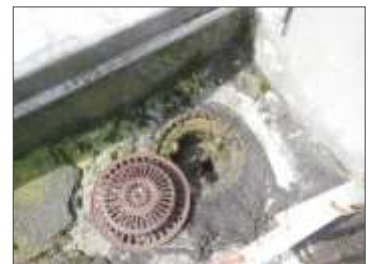
【屋上の排水口】
