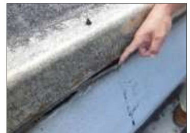
【屋上防水の立上り】
