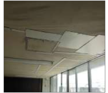
【室内天井の剥がれ】
