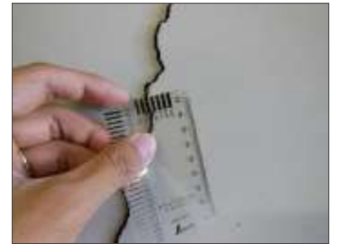
【室内コンクリート壁のクラック】
